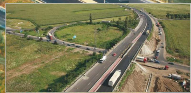
Проект Восточной окружной дороги длиной в 12.8 километров включал в себя расширение дорожных полос с 2 до 4 и выполнение 5 переходов, один из которых имел более 15 железнодорожных линий. Дорожное покрытие сделано из модифицированного полимерами битума, что является альтернативной технологией удваивающей срок службы дороги. Окружная дорога Ploiesti имеет профиль автомагистрали и является одной из самых проходимых подъездных дорог столицы.
